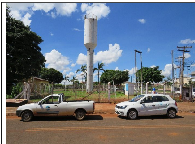
Autor: AMAE/RIO VERDE Descrição: ausência de placas de identificação no SR Valdeci Pires.
